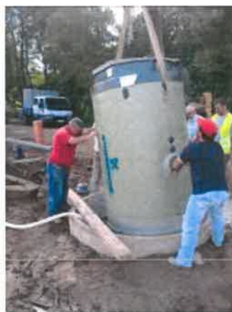
Colocação do Poço de bombagem em obra
