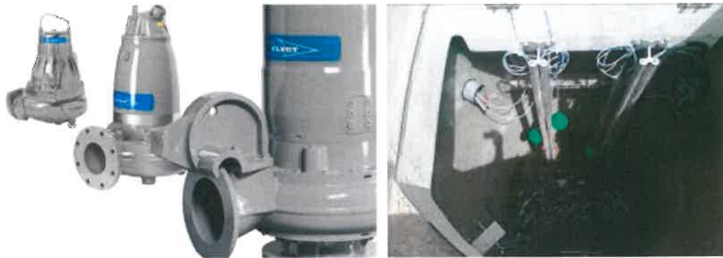
Instalação de equipamentos no poço de bombagem
