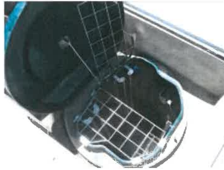
Acabamentos superficiais no Poço de bombagem – aplicação de tampa
