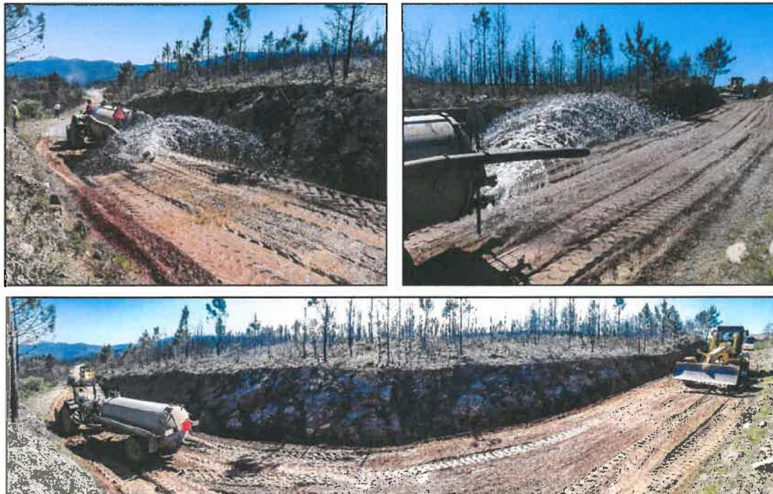
3. Espalhamento da camada de solo, recorrendo a motoniveladora:
