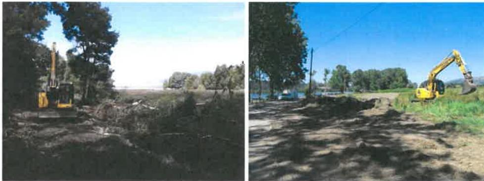
Realizada a desmatção e a limpeza da área segue-se a decapagem de solo vegetal na espessura definida o projeto com recurso a escavadora giratória, descarregando o material diretamente nos camiões que conduzirão o material a depósito provisório para posterior reaplicação.
