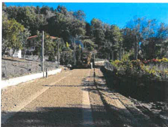
Img. Espalhamento do AGE com recurso a motoniveladora
