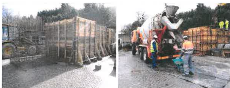
Preparação da cofragem e armadura das caixas em betão armado
