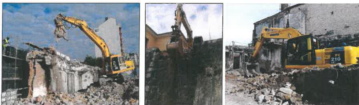
Demolição de muros
