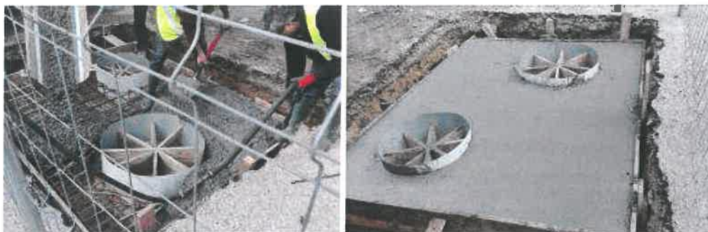
Betonagem de caixas "in situ"
