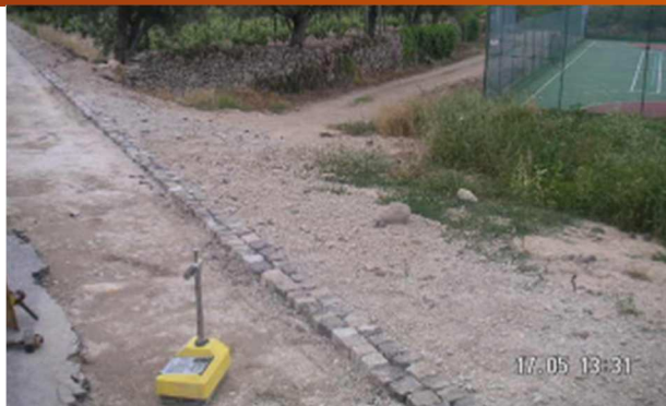
Ensaio nos aterros da vala
