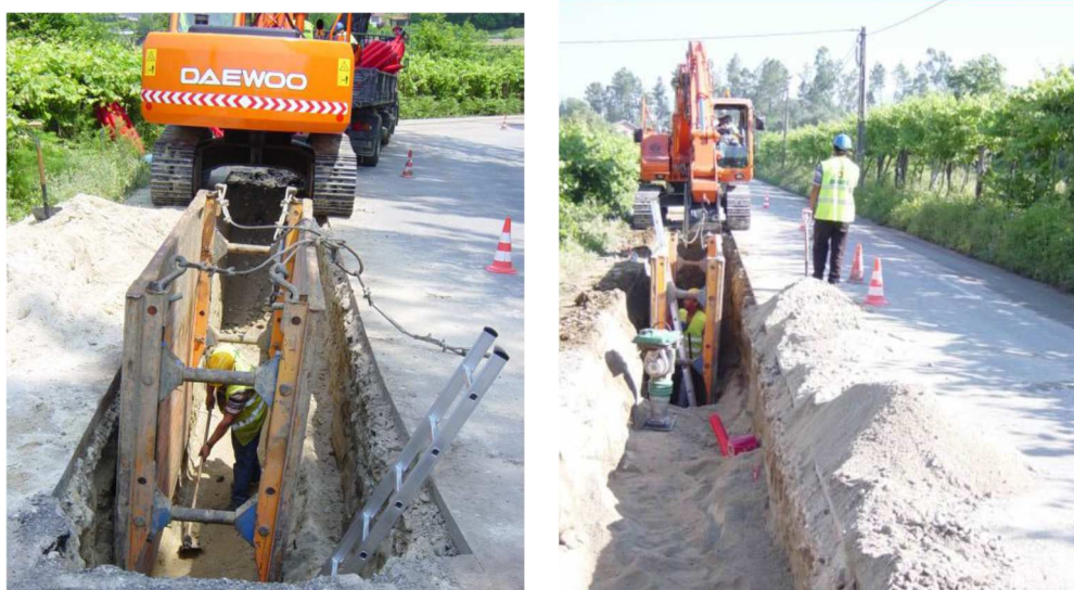
Regularização do fundo da vala
