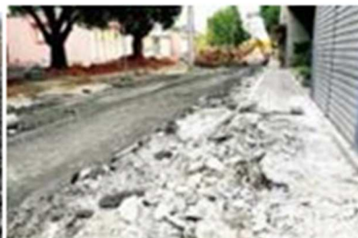
Corte e levantamento de pavimentos
