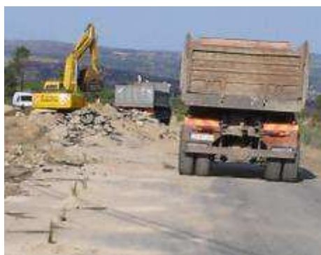
Carga, transporte e descarga a vazadouro
