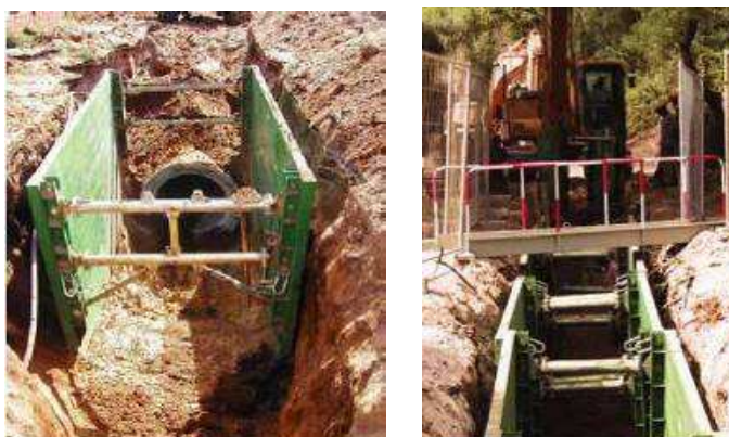
Trabalhos de entivação de valas
