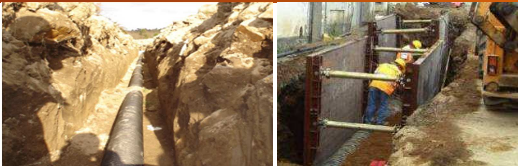
Tubagens em PP corrugado em vala
