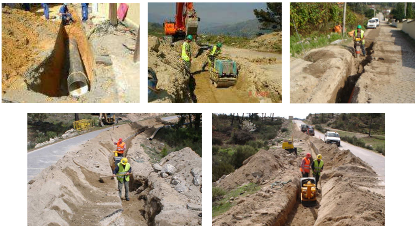
Aterro de valas
