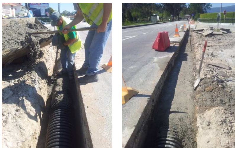
Protecção dos colectores em betão simples
