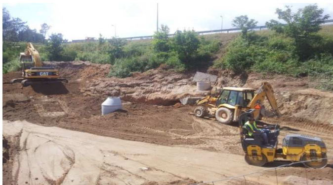
Realização de movimentos de terras
