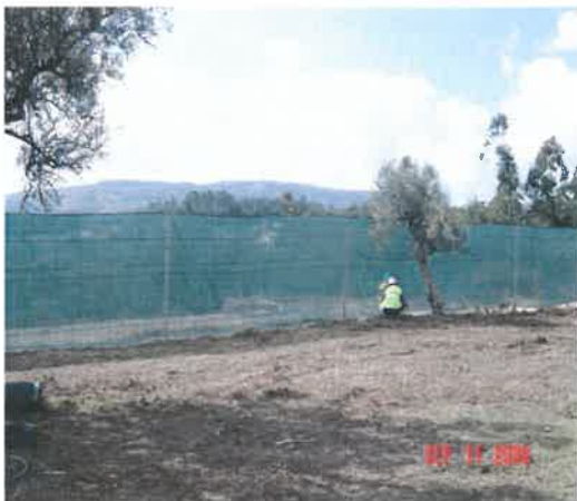
Fig. 1 – Execução de vedação do estaleiro
