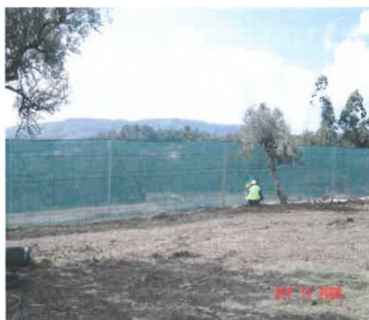
Fig. 1 – Execução de vedação do estaleiro
