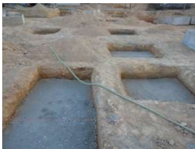
Figura 7 - Betão de Limpeza
