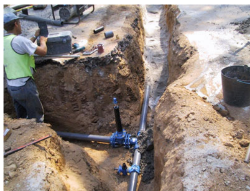
(Instalação de um ramal de abastecimento de água)
