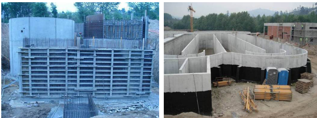
(Execução de estruturas de betão armado)
