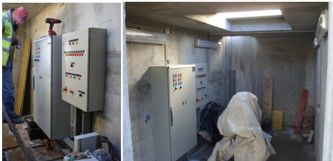
(Montagem de Instalações Eléctricas – Quadros Eléctricos)
