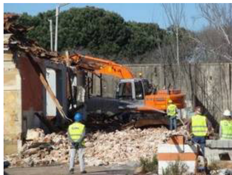
(Trabalhos de demolição de uma estrutura por compressão)
