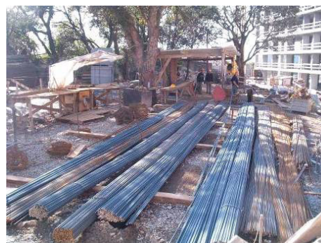
(Aspecto da ferrajaria e varões de aço devidamente armazenados)
