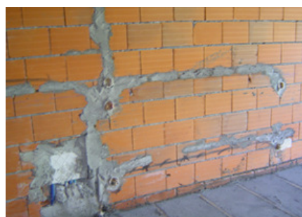
(Assentamento de Alvenarias; Abertura, Instalação das redes e tapamento de roços)
