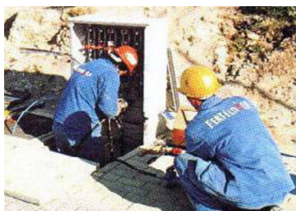
(Montagem de um quadro eléctrico)
