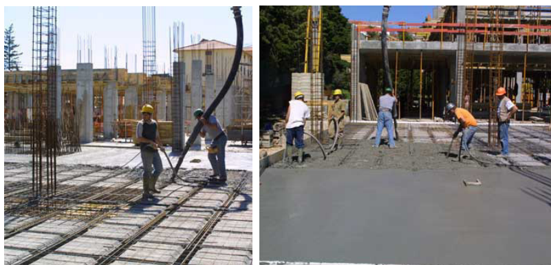
(Trabalhos de betonagem de uma laje de piso)
