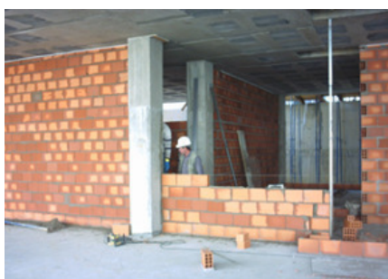
(Assentamento de Alvenarias; Abertura, Instalação das redes e tapamento de roços)
