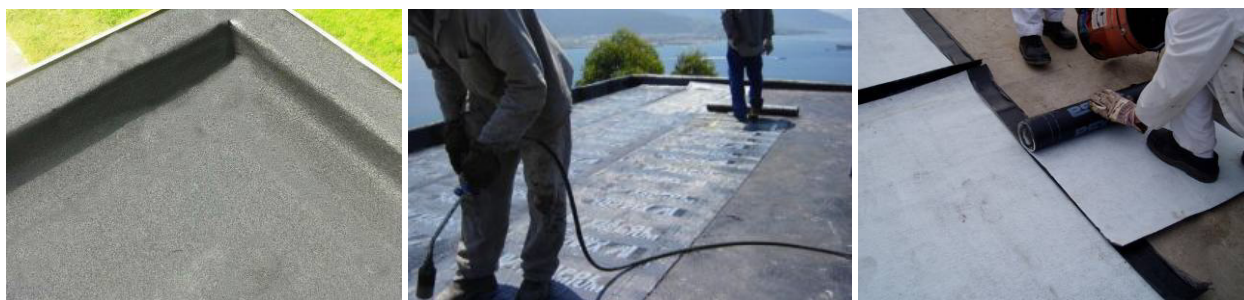
(Aplicação de membrana de Impermeabilização)
