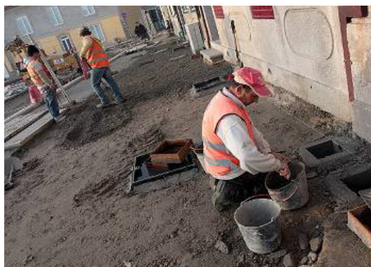
(Servente a rematar uma caixa de ramal)
