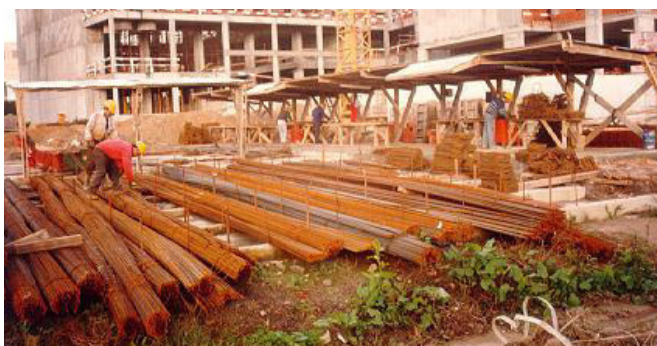
(Aspecto da ferrajaria e varões de aço devidamente armazenados)
