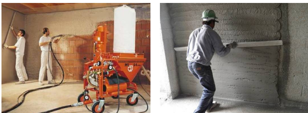
(Aplicação e Acabamento do reboco projectado, respectivamente).
