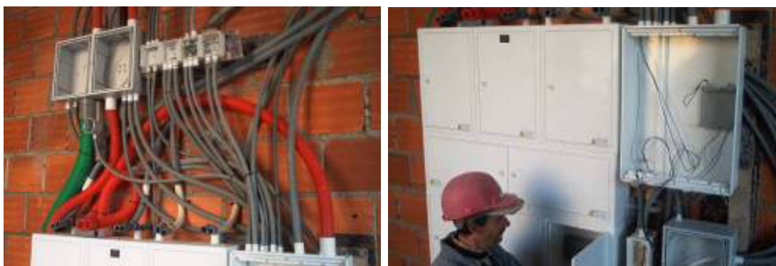
(Execução de instalações eléctricas interiores)
