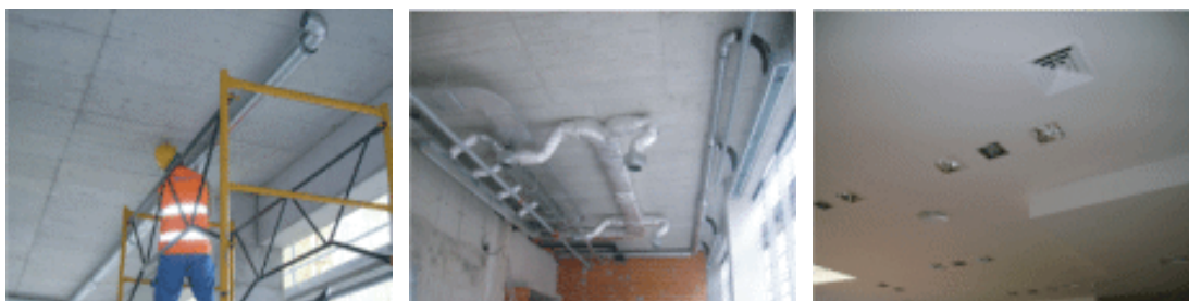
(Diversas fases de uma rede de climatização)
