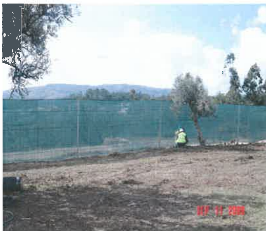
Fig. 1 – Execução de vedação do estaleiro
