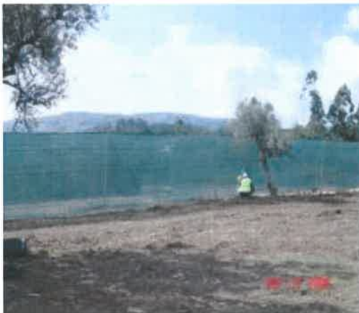
Fig. 1 – Execução de vedação do estaleiro
