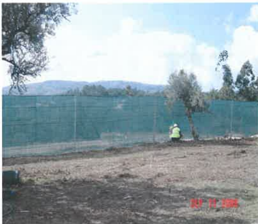
Fig. 1 – Execução de vedação do estaleiro
