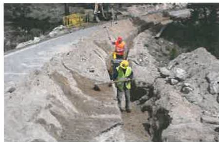
(Trabalhos de aterro de vala)
