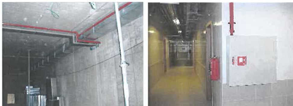
(Aspecto da rede armada e carrete)
