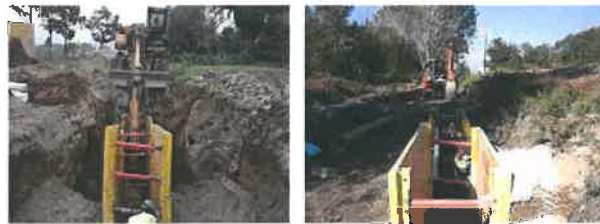
(Utilização de entivações na abertura de valas)
