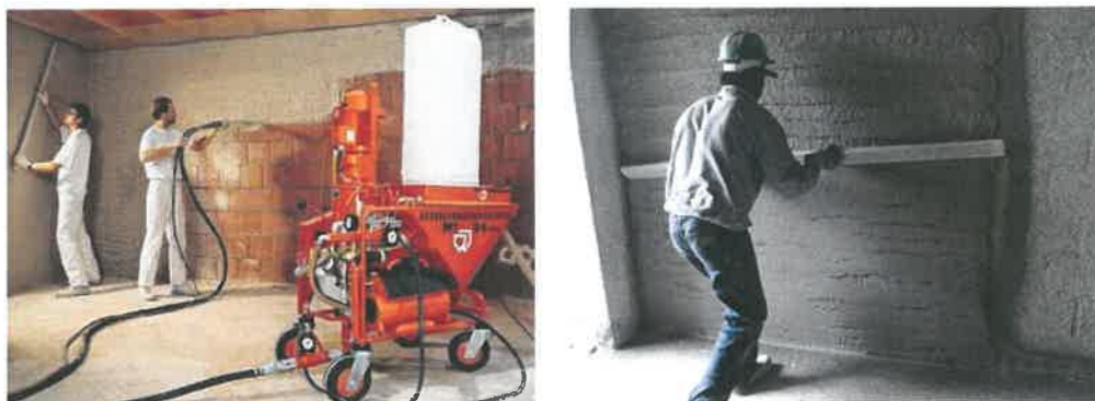
(Aplicação e Acabamento do reboco projetado, respectivamente).
