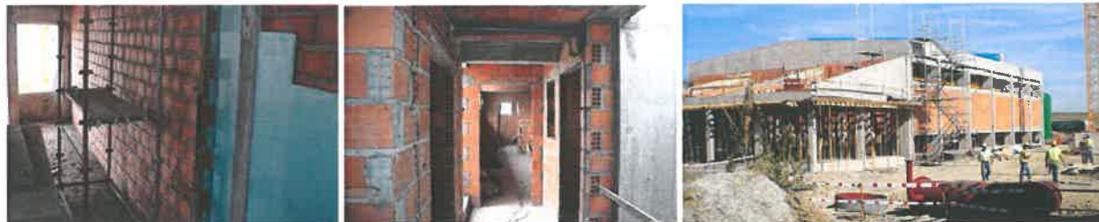
(Execução de alvenaria de tijolo dupla e aspeto final das paredes em tosco)
