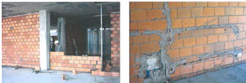
(Assentamento de Alvenarias; Abertura, Instalação das redes e tapamento de roços)
