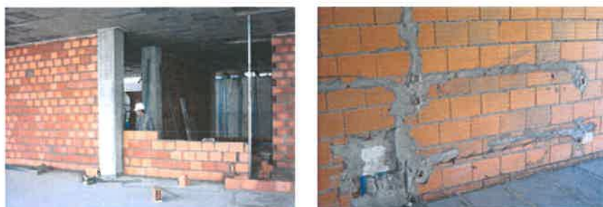
(Assentamento de Alvenarias; Abertura, Instalação das redes e tapamento de roços)
