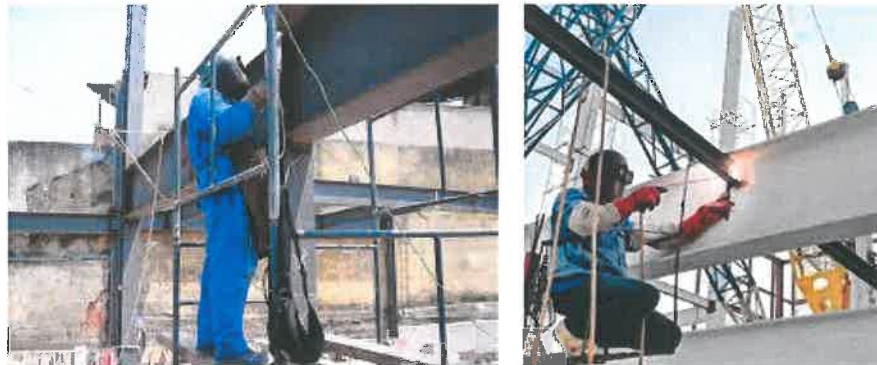
(Montagem de Estruturas Metálicas)
