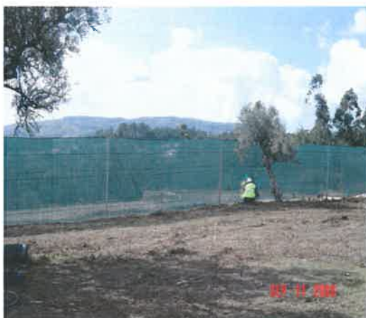
Fig. 1 – Execução de vedação do estaleiro
